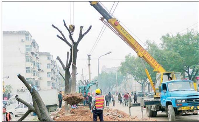
11月9日,为配合和平路改造工程,和平路北侧一些大树陆续就地平移,树木从原位置向北移动了大约两米。施工人员用吊车进行移植。
