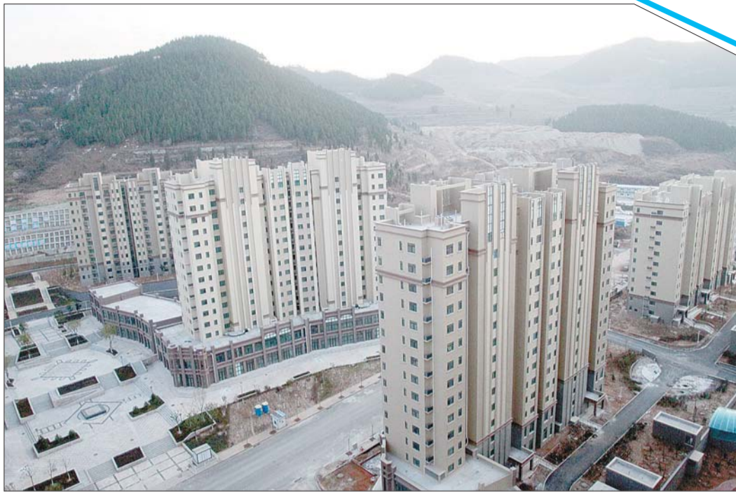
西蒋峪公租房外部装饰装修已经完成。
