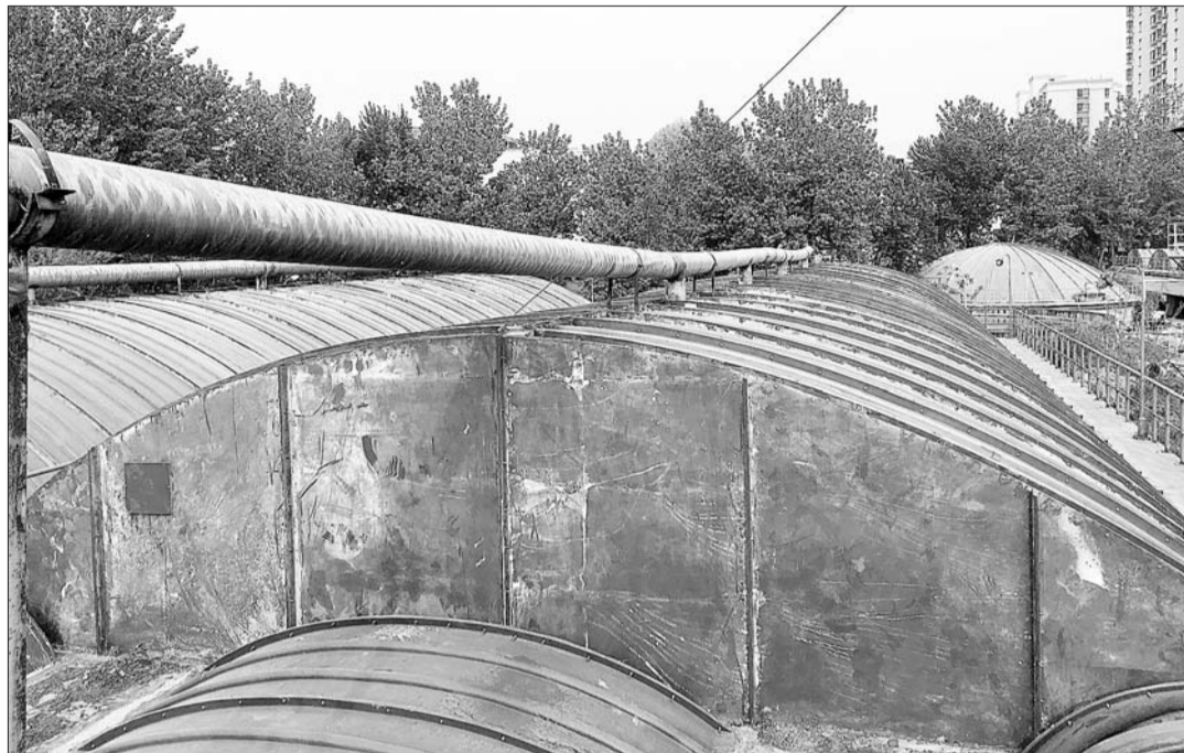
该区域就是药厂污水处理区，与历城二中教学楼仅一墙之隔。
