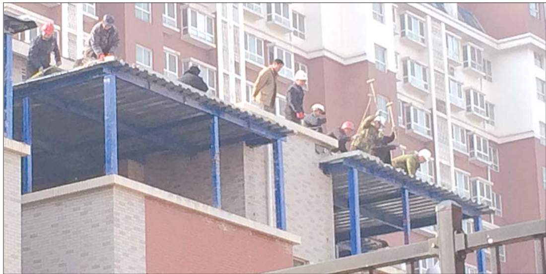
执法人员在拆除露台上的违建。
