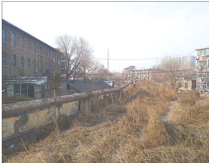
受废弃铁路路基影响,经十一路片区交通都很落后。记者 王僖 摄
