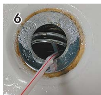
清理掉吸管上的头发后再把吸管插进排水孔,重复几次就清理好了。
