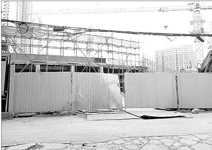
停工令发布后,不少项目工地的工人已经暂时放假。 记者 张敏 摄
