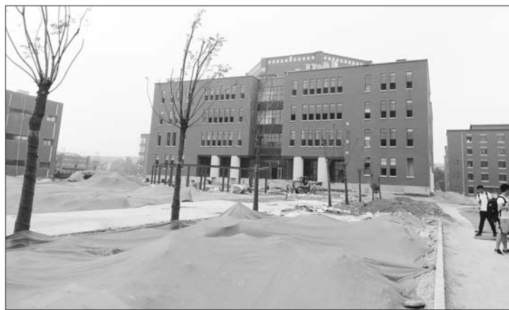
11日，大学城实验高中施工现场。
