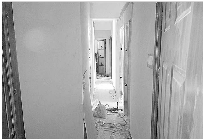
房子仍在装修中,原本开阔的走廊变得十分狭窄。
