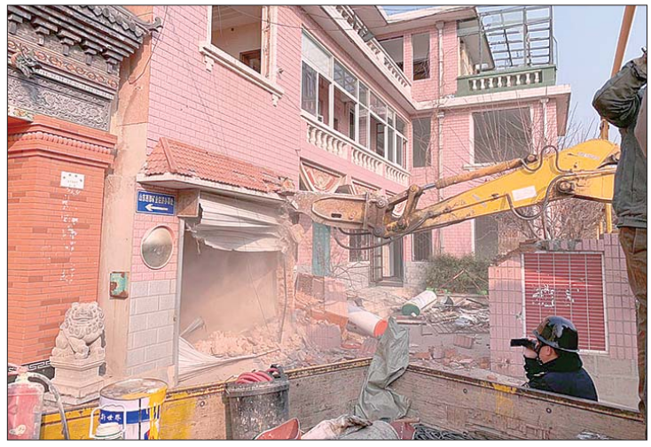
挖掘机进场,对别墅进行拆除。
