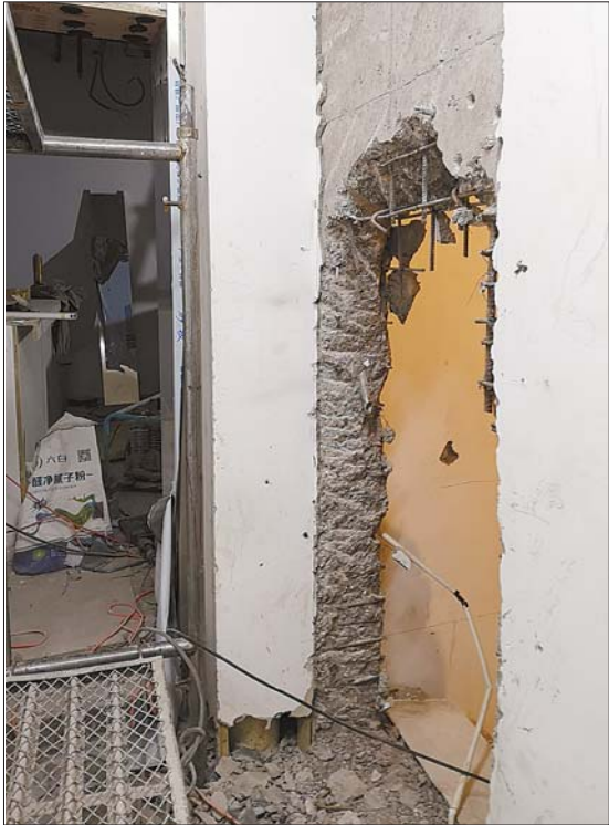
被砸开的带钢筋的墙体。 本报记者 王皇 摄
