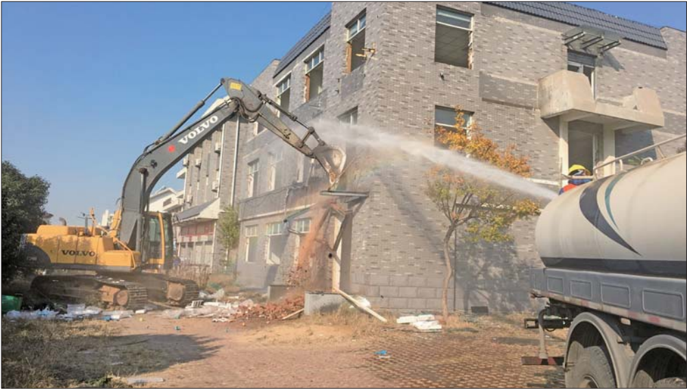
拆违现场。 本报记者 张帅 摄
