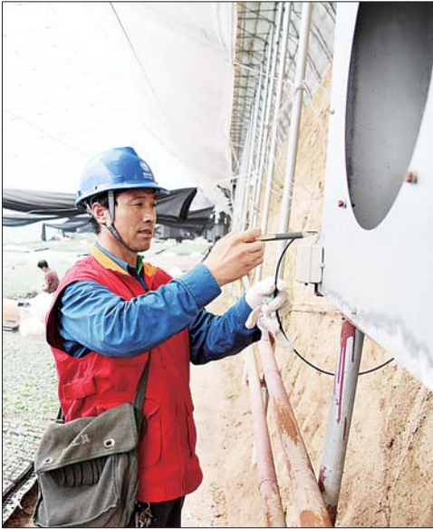
济阳供电员工定期走进大棚区进行安全用电检查。
