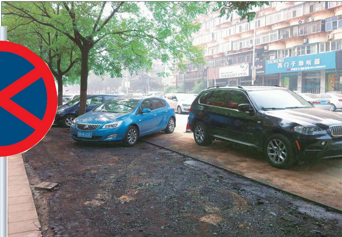
23日泺文路人行道继续施工,车辆还能停在道路两侧。
