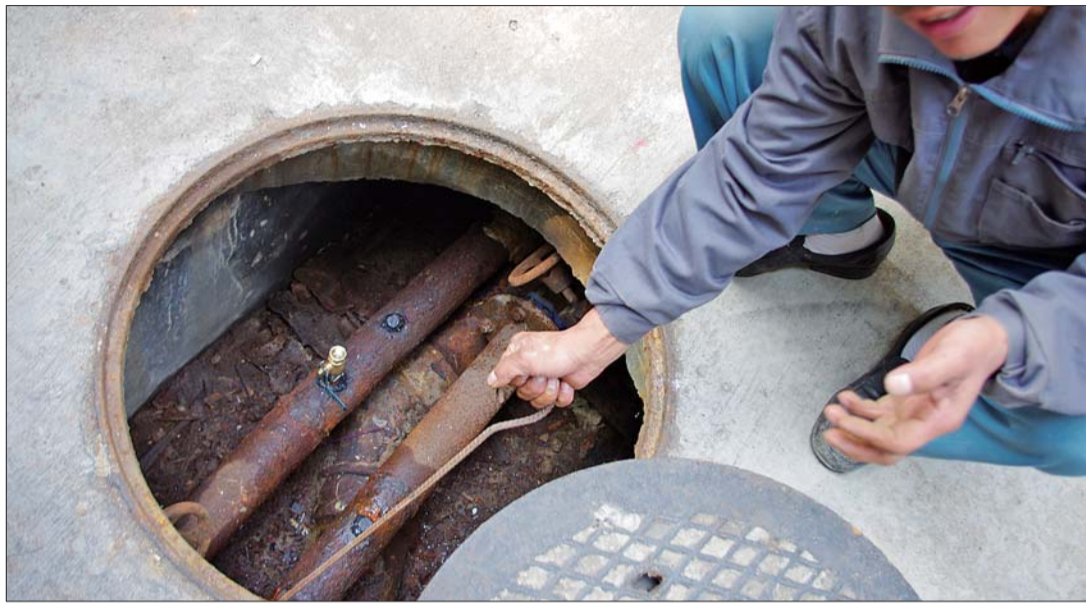
开元山庄小区内锈蚀的暖气管道。
