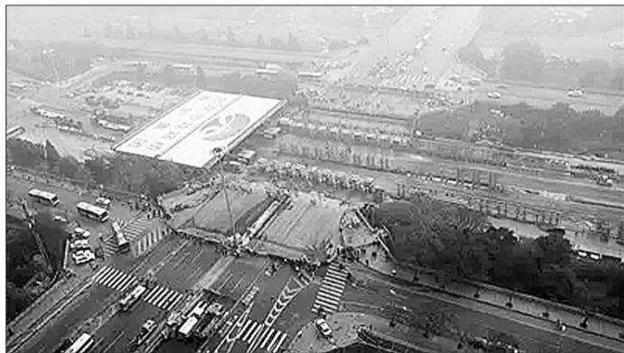
15日上午9时，1350吨的新桥梁开始移动。
