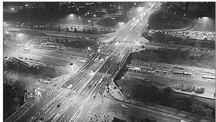
15日晚上6时，三元桥桥区全线通车。
