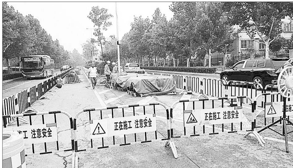
热力改造施工现场。
