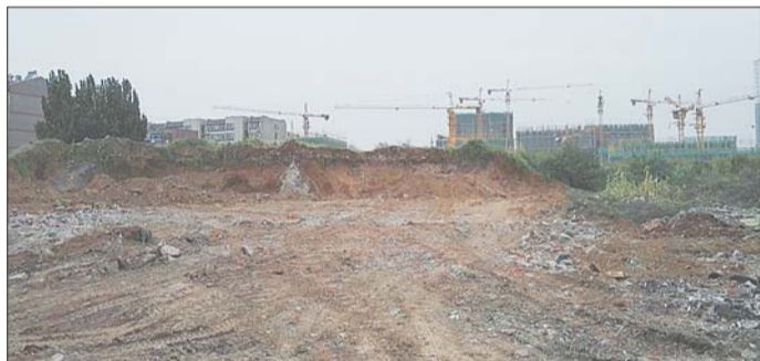
殷陈小学新校区已经开工动土,但现场无施工人员。 记者 程凌润 摄
