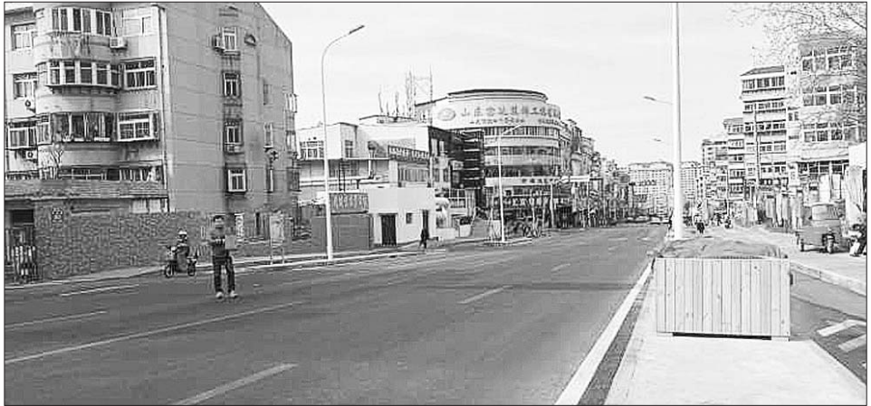
环山路经改造通车近半年来,全线道路还没有配置垃圾箱。
