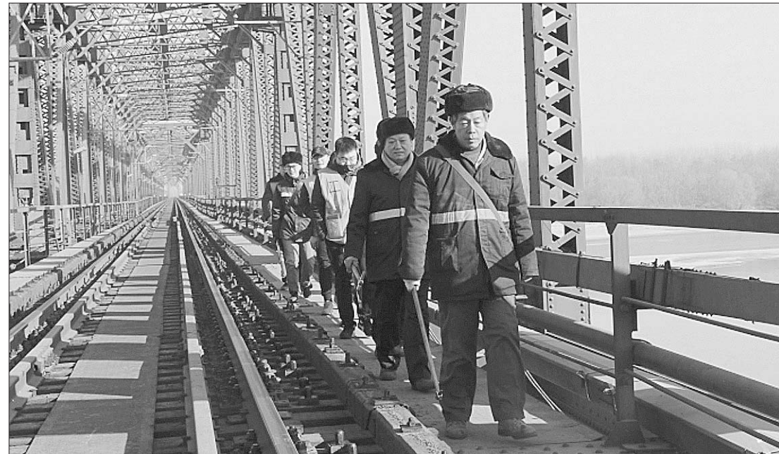
护桥工人早上8点利用天窗点开始上桥作业。
