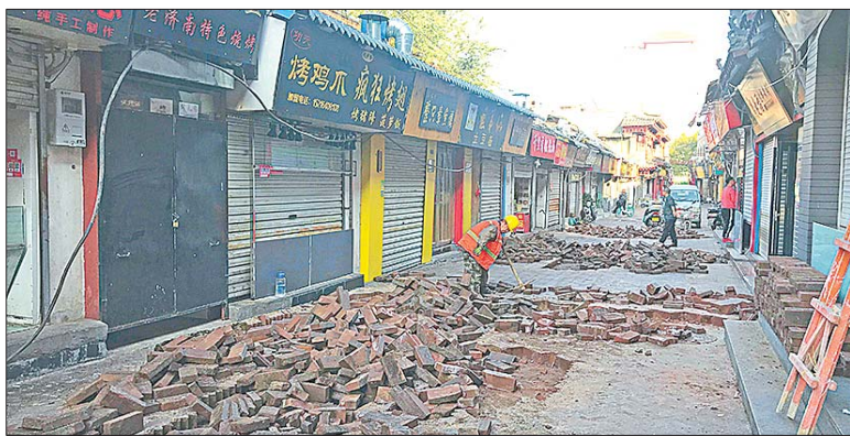
芙蓉巷封闭施工,明年元旦重新开街。
